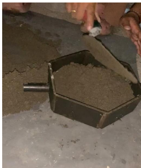
Gambar 3. Pencetakan Paving Block
